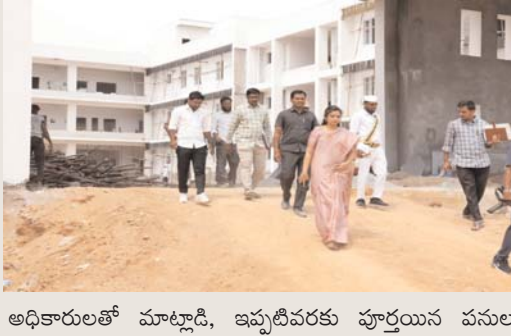
అధికారులతో మాట్లాడి, ఇప్పటివరకు పూర్తయిన పనుల పురోగతిని తెలుసుకున్నారు. "నిర్మాణ పనుల్లో మరింత వేగం పెంచాలి. భవనం పూర్తయ్యే ముందు బాహ్య రోడ్లు, డ్రైనేజీ, ల్యాండ్ సేఫ్టింగ్ వంటి చుట్టూ ఉన్న సౌకర్యాల పనులు వెంటనే ప్రారంభించండి" అని సూచనలు సూచనలు చేశారు. జూన్ 2026లోపు అన్ని పనులు 100% పూర్తి చేయాలని ఆర్ అండ్ బి ఈ.ఈ. వెంకటరమణ, డి.ఈ. రామయ్య, ఎ.ఈ.లకు కఠిన ఆదేశాలు జారీ చేశారు. ఈ
